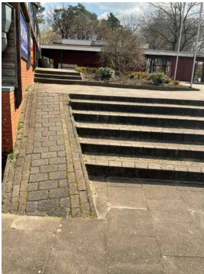
Abbildung 22 a & b: Das neue Funktionsgebäude am Sportzentrum Osterwald und die Zuwegung zum Stadion.
