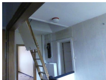
Abb. 11: Erstes Stockwerk mit Treppe zum Dachboden
