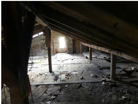
Abb. 12: Dachboden des Ladengebäudes
