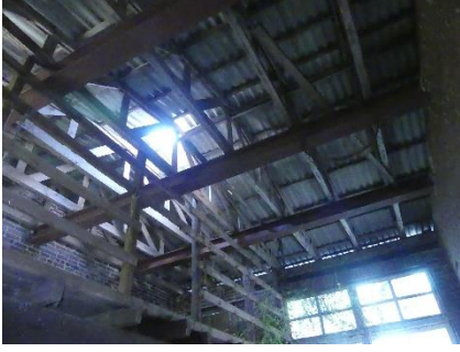
Abb. 18: Schlachthaus, Blick zur Decke
