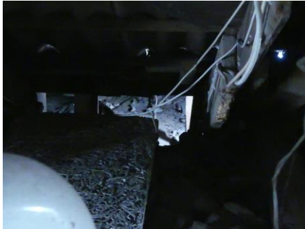
Abb. 16: Öffnung im Dachboden des Ladengebäudes nach Osten
