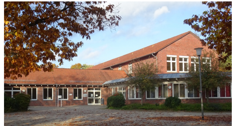
GS Osterwald (7000019020) Bodenbelagsarbeiten, Brandschutztüren, Trennwände Sanitäreanlagen
