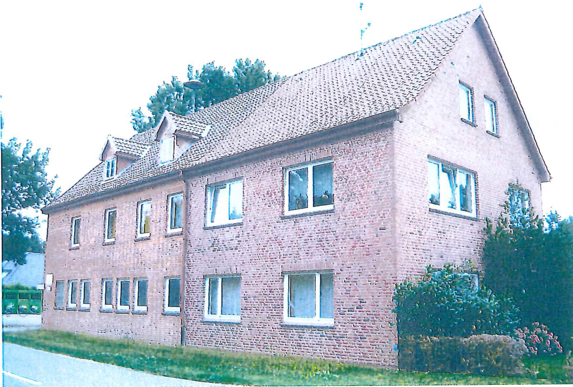
Wohn- und Geschäftshaus von Südwesten
